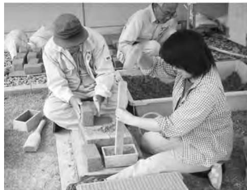
ブロックの木枠（内寸：幅11×長19×深7.5cm）
