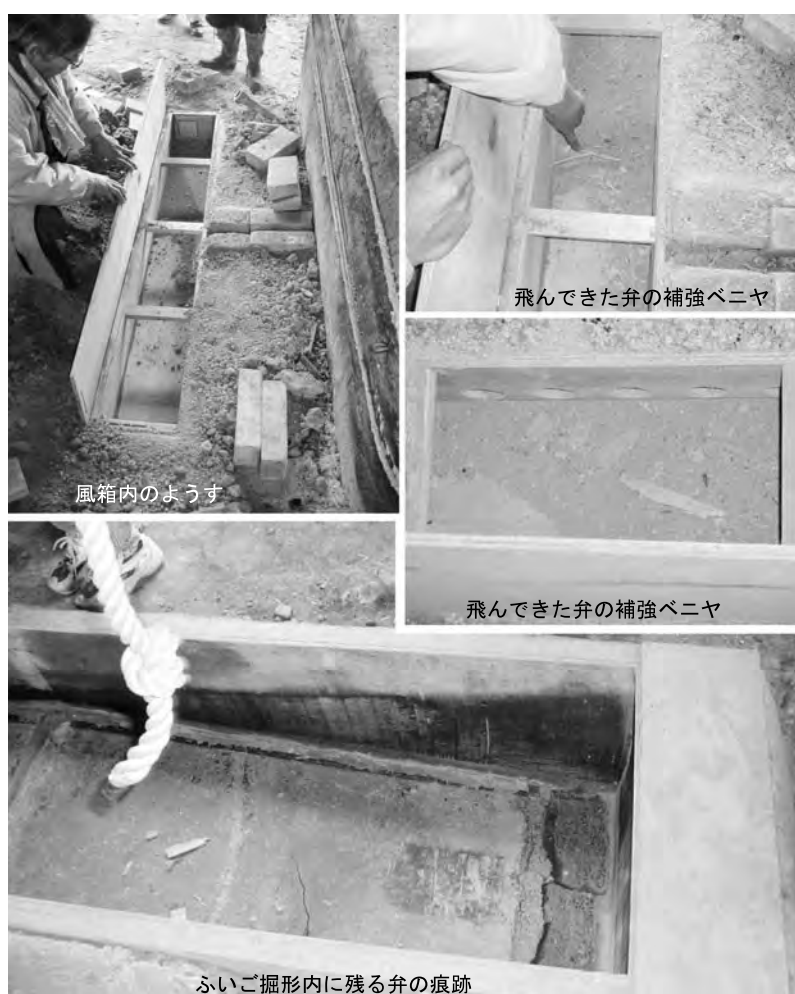
図 12 空気取り入れ弁と送風孔のズレと風箱内のような
