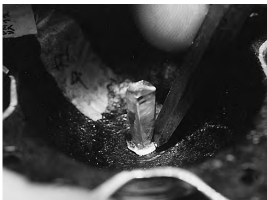
写真40 鑿による割り込みを行った状態
