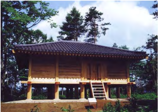
復元された正倉建物
