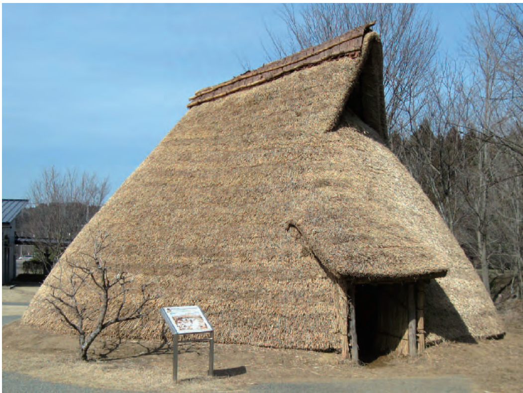
東日本大震災により被災し、修繕を終えた「縄文時代の家」（平成 24 年 3 月 26 日）
