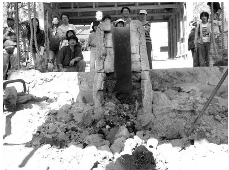
写真10 炉解体のようす
