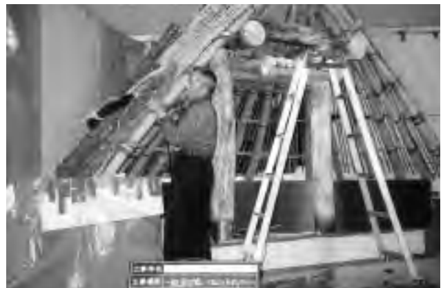
屋内展示工事のようす
