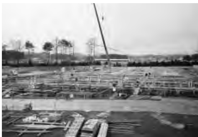
建築工事（平成11年12月）
