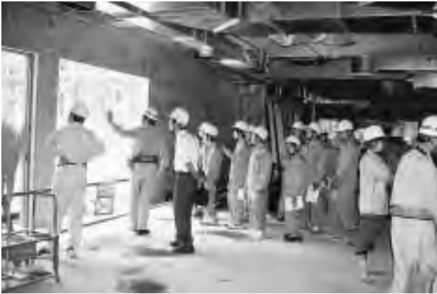
高校生の建築工事現場見学会
