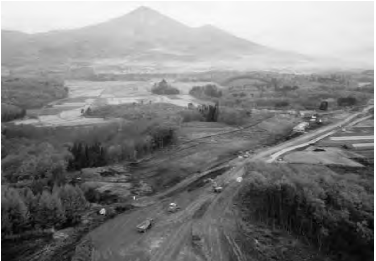
磐梯町法正尻遺跡の調査
