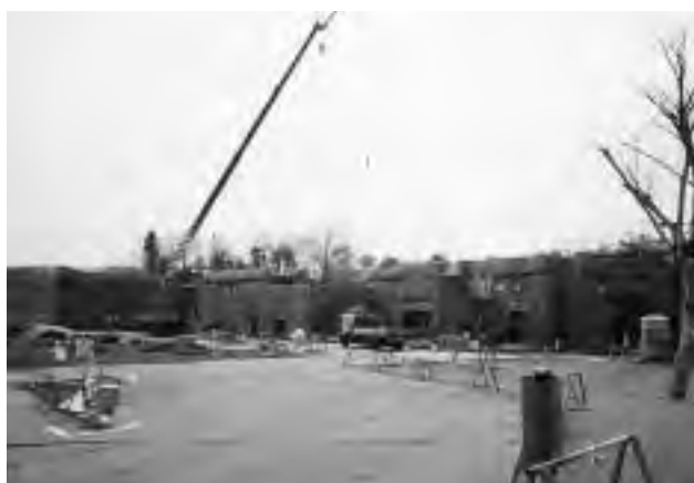
建築工事（平成12年4月）
