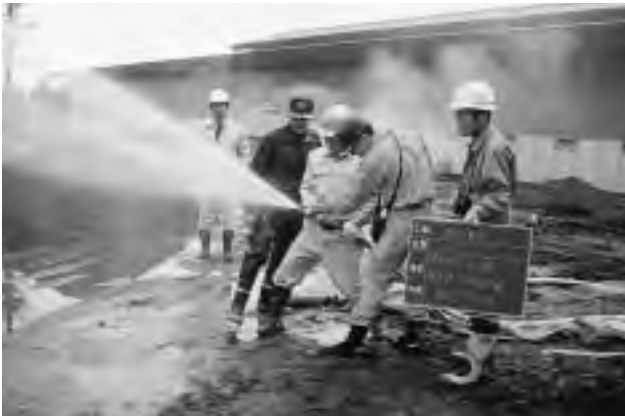
消火栓の消防検査
