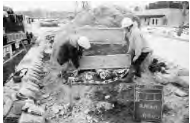
銘板の取り付け工事
