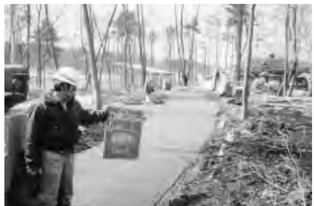
園路の舗装工事
