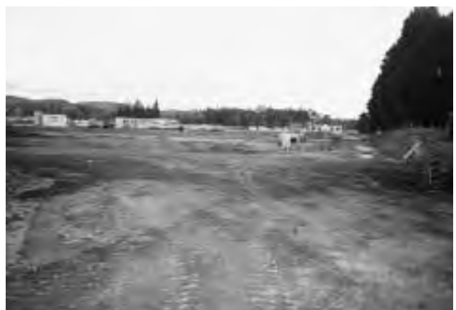
造成中の敷地(2)
