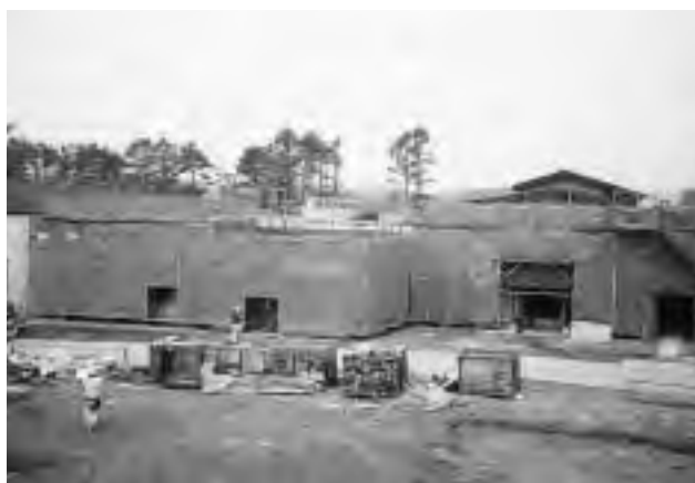
建築工事（平成12年7月）
