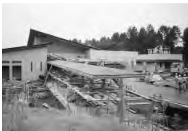
建築工事（平成12年8月）
