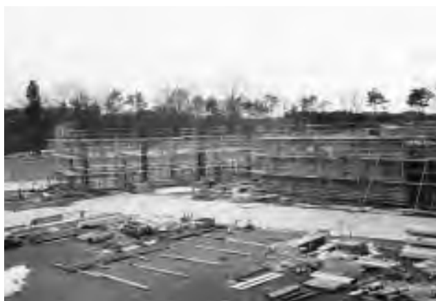
建築工事（平成12年3月）
