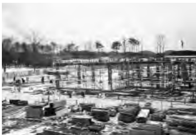
建築工事（平成12年2月）
