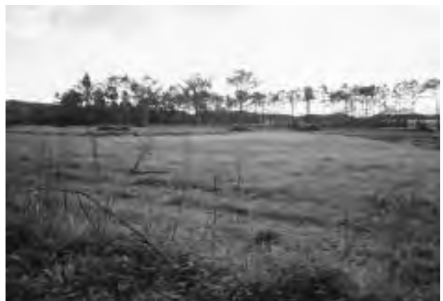
造成中の敷地(1)
