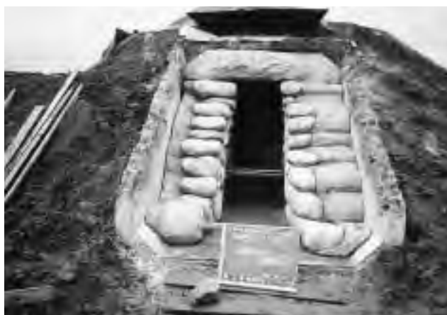
古墳石室の工事
