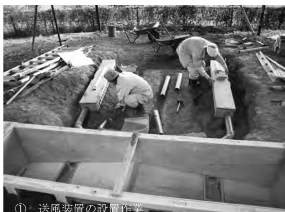
① 送風装置の設置作業
